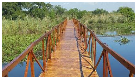
Figura 18. Pasarela que recorre la zona de visita.
