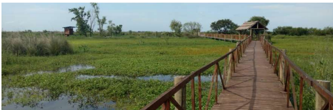
Figura 17. Pasarela que recorre la zona de visita.
